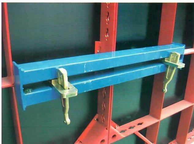
Montaje con vigas rigidizadoras
