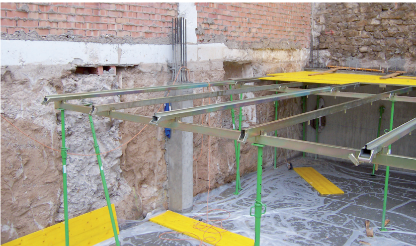
Comienzo de montaje desde una esquina.
