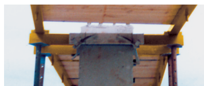
Detalle de la Guía posicionada al pilar .
