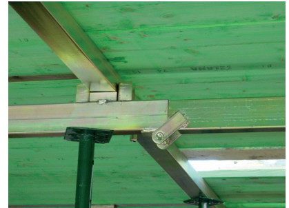
Detalle de unión con otra Guía así como el alojamiento de la Sopanda y la posición del puntal.
