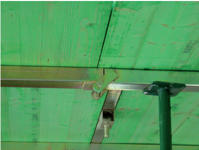
Detalle de unión con otra Sopanda así como la posición del puntal.
