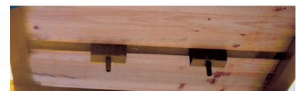
Detalle del Crucero en su posición cada 2 tableros.
