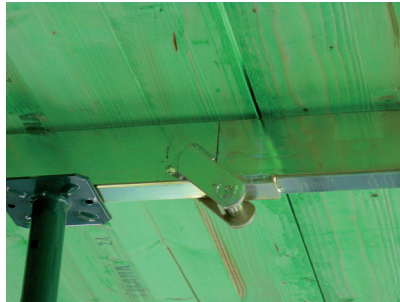
Detalle de unión con otro Intermedio así como la posición del puntal.
