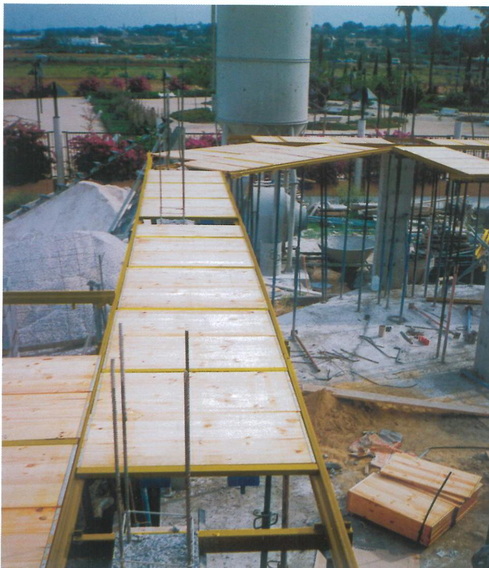
Ce système de coffrage horizontal permet la construction facile et rapide de structures à fondation continue.
