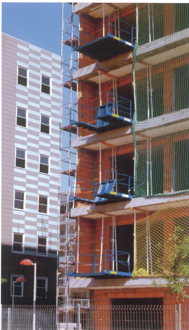
La plateforme métallique Maquiobras facilite le déchargement des matériaux de construction à chaque étage du bâtiment. Son utilisation est recommandée en complément de la grue.
