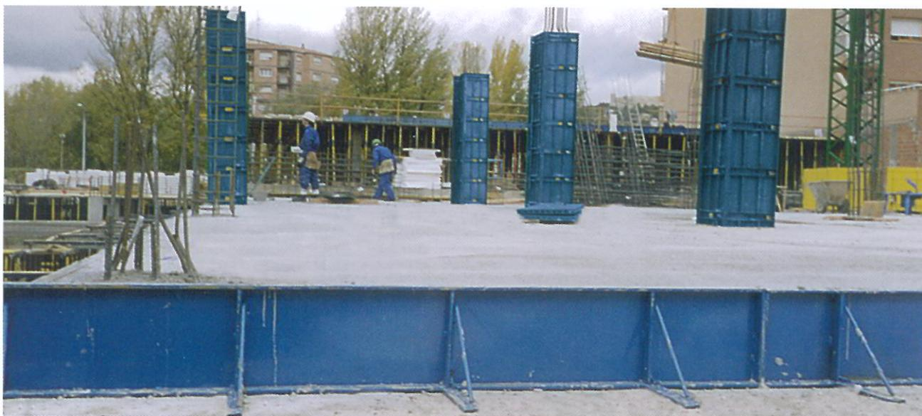
Les cloisons périphériques sont une bonne option pour maintenir le béton en place dans les constructions de dalles lisses.
