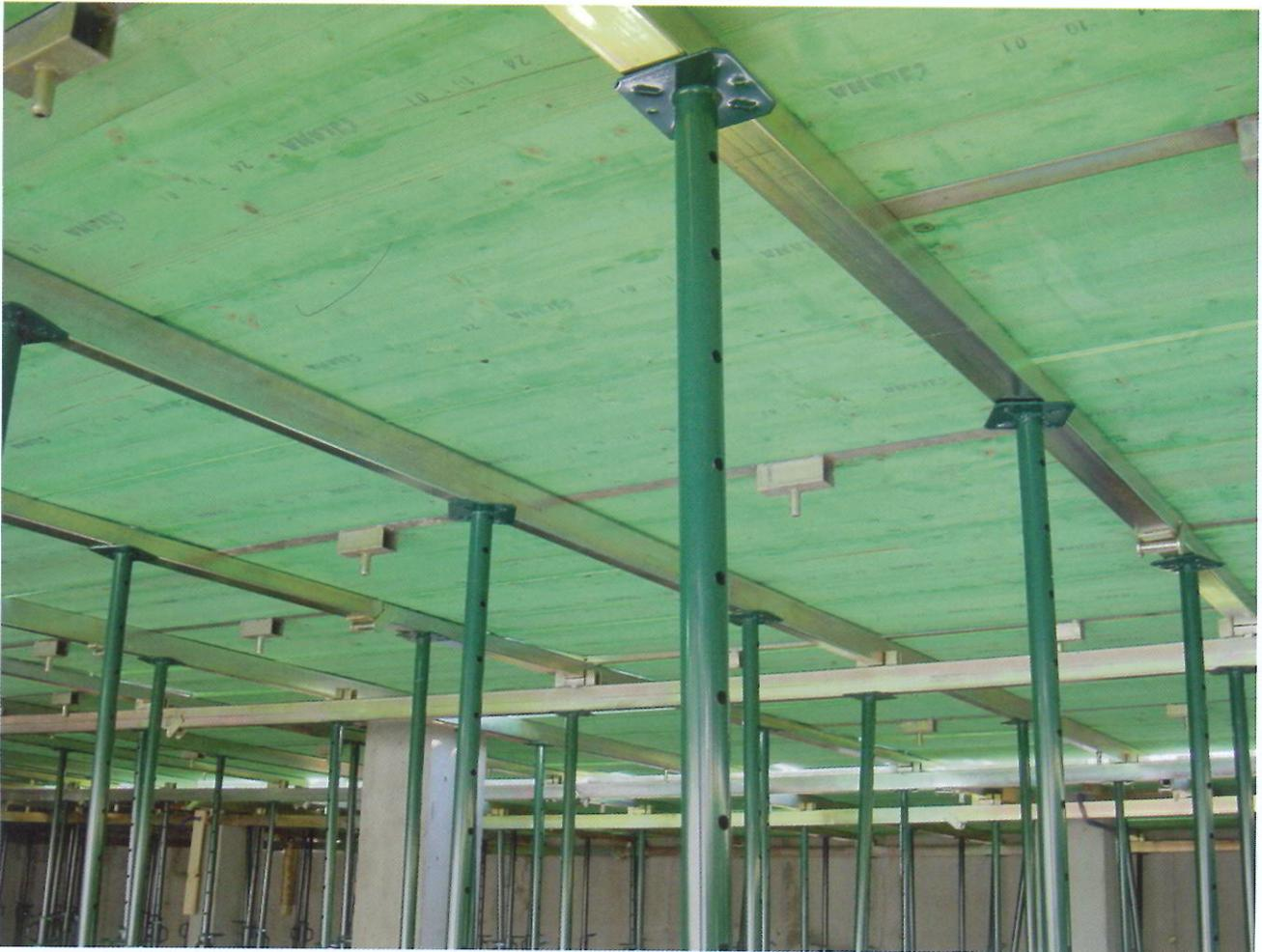
Assemblage et démontage simples et rapides pour l'installation des panneaux sur toute la surface du chantier.
